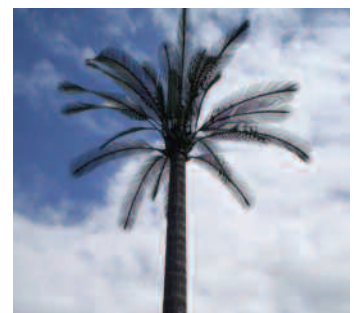
pylône monopode intégré en forme de palmier
