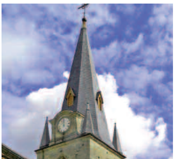
pylône monopode intégré dans le clocher
